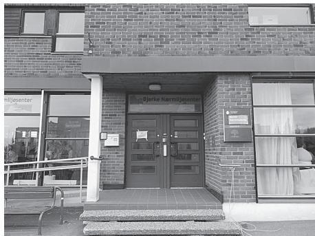
写真7. センター外観
