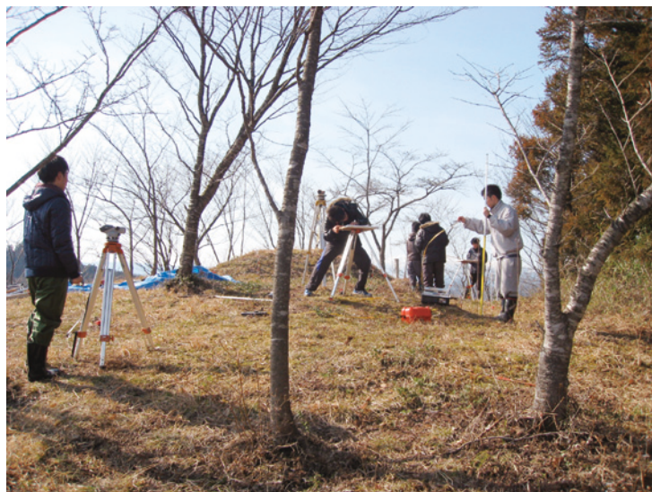
写真1 測量調査風景
