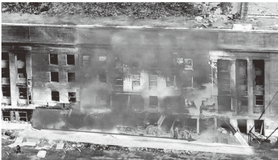
図3 (激突直後 E Section 崩壊前) 2)
