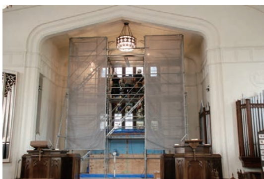
礼拝堂内足場
