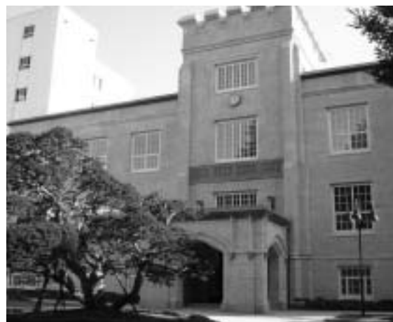
耐震工事が終わった土樋キャンパス本館
