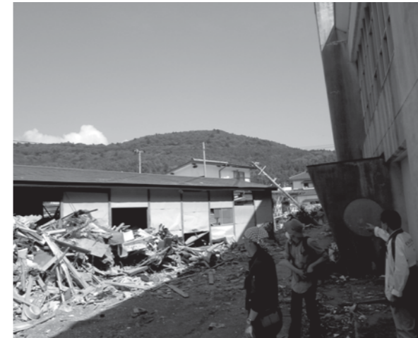
写真1 鮎川収蔵庫の被災状況
