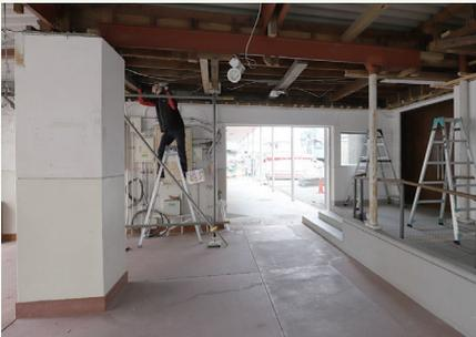
fig1 現場全景。上部の鉄骨より奥に竣工時の部材が残る。左の柱の中にも竣工時の雨樋と装飾壁が残存（崎山撮影）
