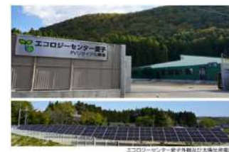
使用済み太陽光パネル リサイクル工場
