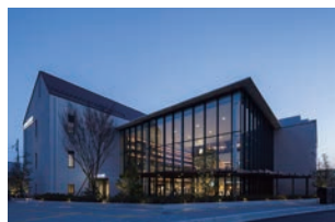
多賀城市立図書館
