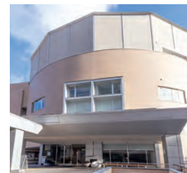
8号館2F入口
