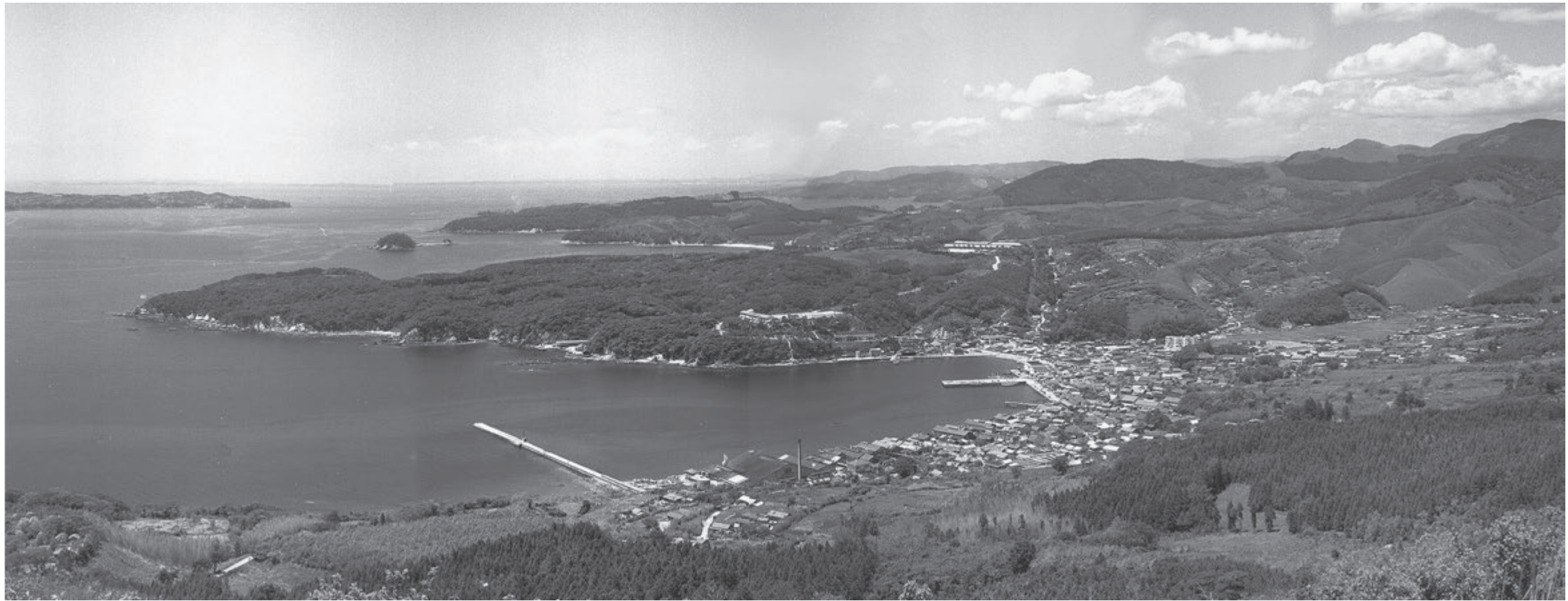
㊦の事業所と煙突、そして昭和41年建設の漁民アパートが写っており、これからコバルトラインが開通し、鮎川が捕鯨から観光へと移り変わる節目の風景写真です。(成澤)
