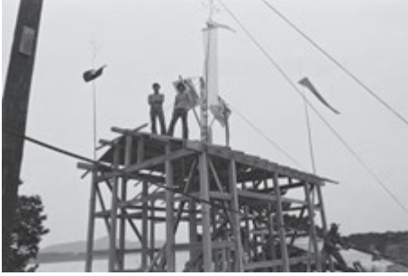
上棟の様子（撮影：鹿井清介）
